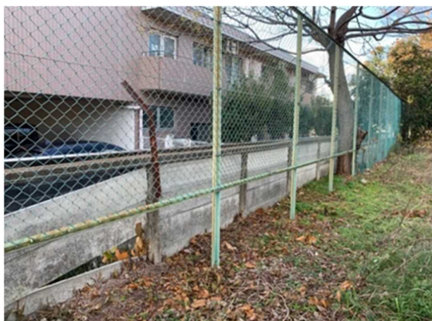
(越後屋敷) 囲障改修
